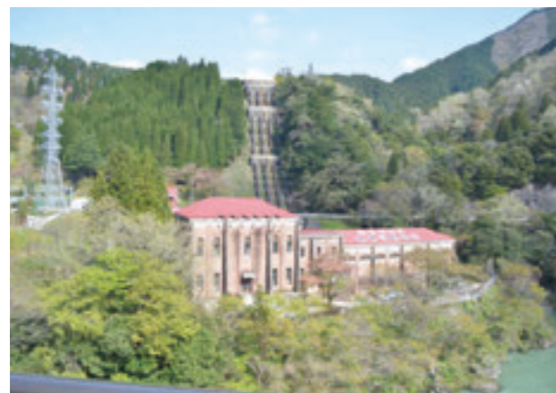
東横山発電所
