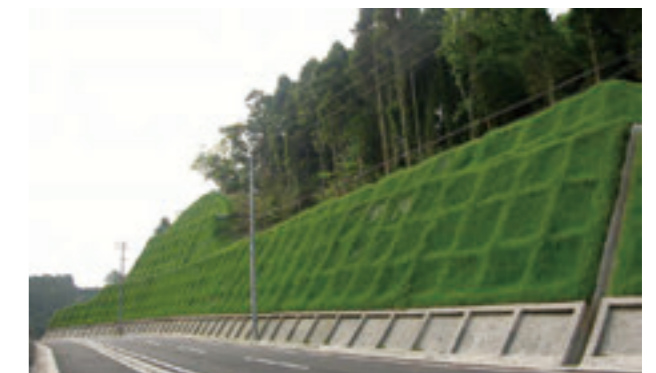
GTフレーム工法 ® によるのり面
