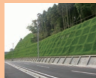
GT フレーム工法 (法面工事)
