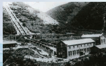
西横山発電所(1916年頃)
