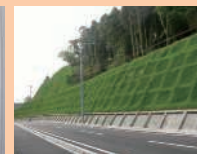
GT フレーム工法 (法面工事)
