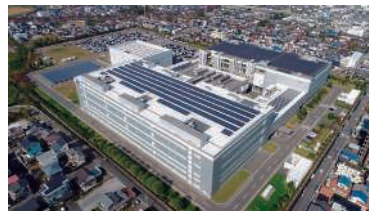
大垣中央事業場 全景
