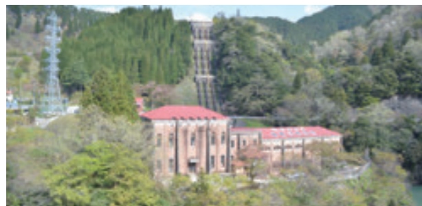
東横山発電所
