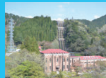
東横山発電所
