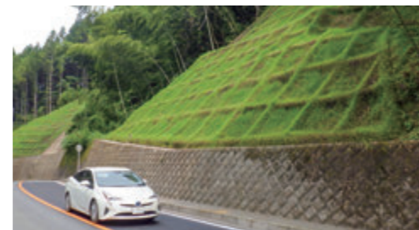
GTフレーム工法®によるのり面
