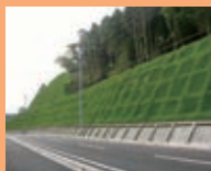
GT フレーム工法 (法面工事)
