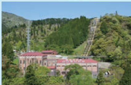
東横山水力発電所
