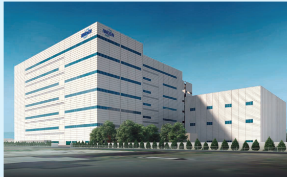
河間事業場 新棟竣工イメージ
