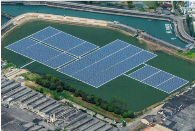
衣浦事業場 水上フロート式太陽光発電所
