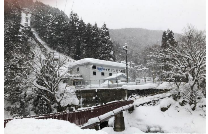
川上水力発電所
