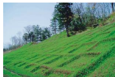
GTフレーム工法®による法面
