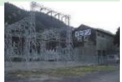
広瀬水力発電所（2012年度更新完了） 発電能力 8,900キロワット
