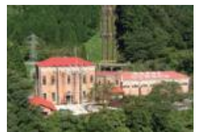
東横山水力発電所（2015年度更新完了） 発電能力 14,600キロワット
