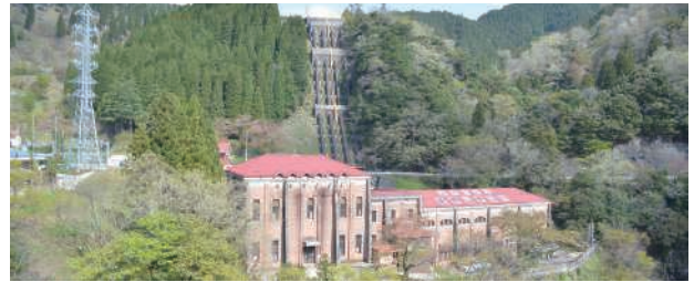
水力発電(東横山発電所)
