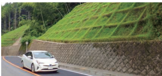
GTフレーム工法 ® によるのり面
