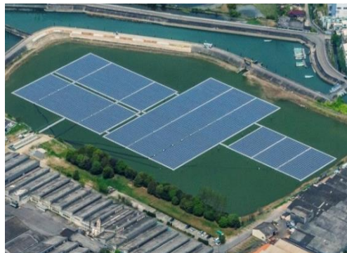
衣浦事業場 水上フロート式太陽光発電所
