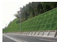
GT フレーム工法(法面工事)
