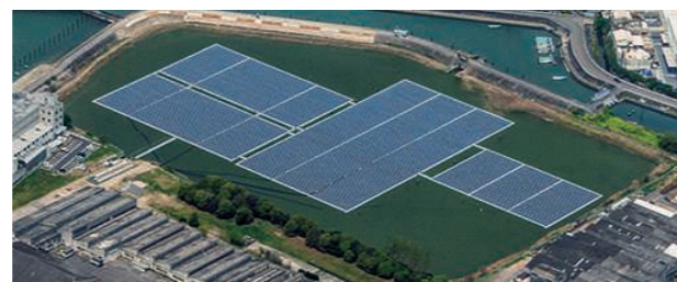
水上フロード式太陽光発電所(衣浦事業場)
