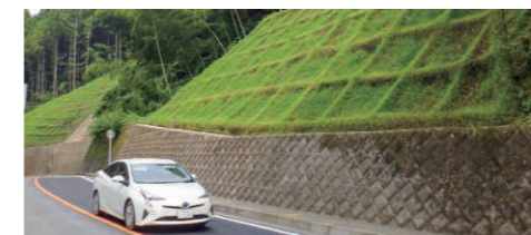
GTフレーム工法 ® によるのり面
