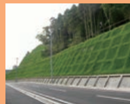
GT フレーム工法 (法面工事)
