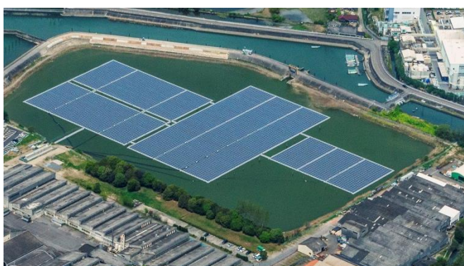
衣浦事業場 水上フロート式太陽光発電所
