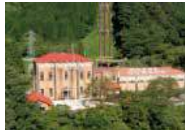
東横山水力発電所（2015年度更新完了） 発電能力 14,600キロワット
