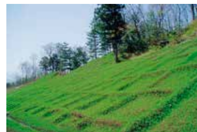
GTフレーム工法®によるのり面
