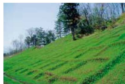
GTフレーム工法®によるのり面
