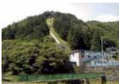
川上水力発電所（2014年度更新完了） 発電能力 4,400キロワット
