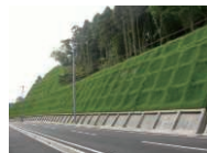
GT フレーム工法(法面工事)
