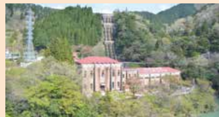
東横山発電所
