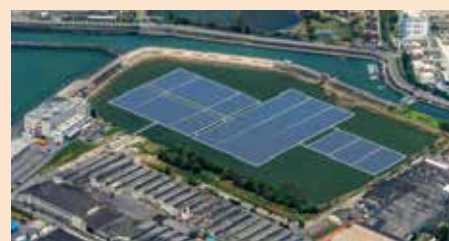
衣浦事業場 水上フロート式 太陽光発電所
