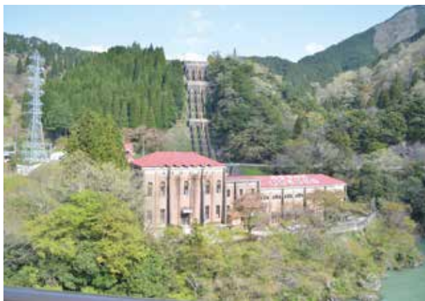
東横山発電所
