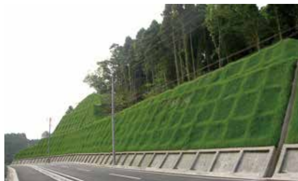
GTフレーム工法®によるのり面
