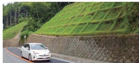
全面緑化を施した法面
