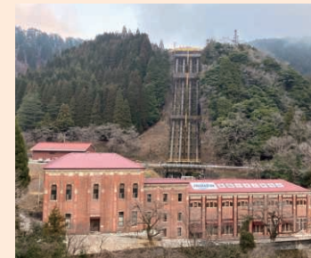
工事が完了した東横山水力発電所
