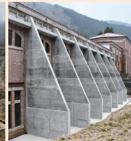
控え壁による補強
