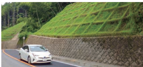
GTフレイム工法 ® によるのり面
