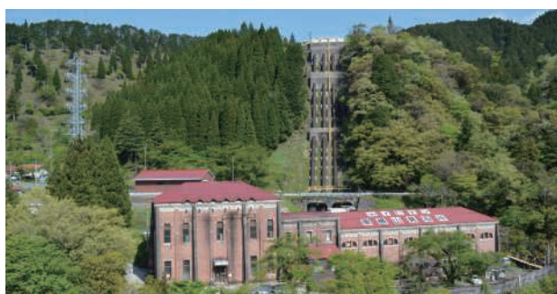
東横山発電所
