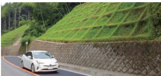
GTフレーム工法<sup>®</sup>によるのり面
