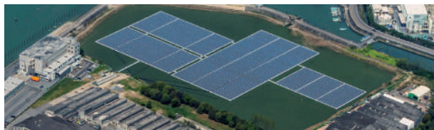
水上フロート式太陽光発電所(認定出力 1.99MW)
