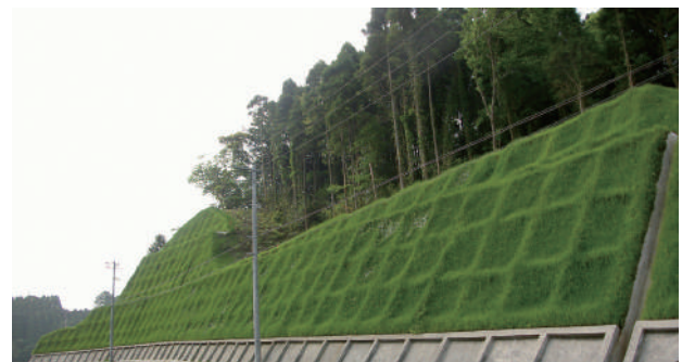
GTフレーム工法®によるのり面
