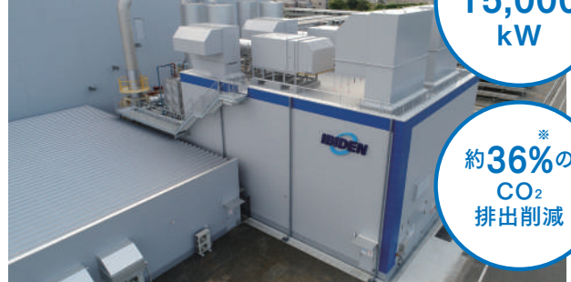
ガスエンジンコージェネレーションシステム
