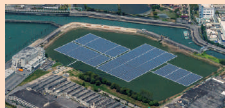
衣浦事業場 水上フロード式 太陽光発電所
