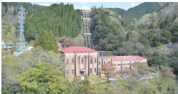
東横山発電所
