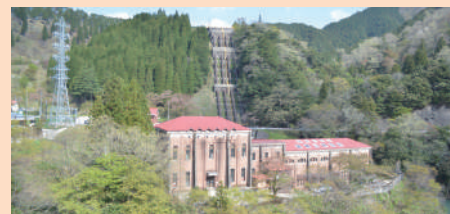
東横山発電所
