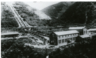
① 西横山発電所(1916~1963)
