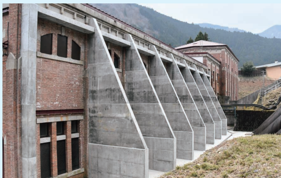
耐震補強工事が完成した東横山水力発電所
