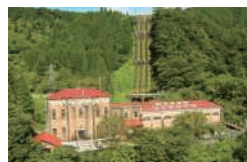
東横山発電所
