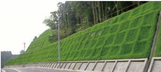
GTフレーム工法(のり面工事)【イビデングリーンテック(株)】
