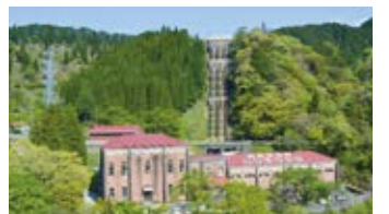
東横山発電所
