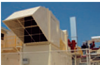
コージェネレーションシステム 当社の事業場構内でコージェネレーションシステムを稼働しています。
