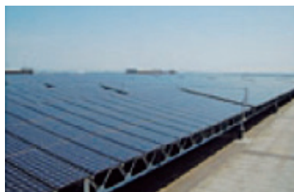
太陽光発電システム 定格発電出力647キロワットの太陽電池パネルが本社・大垣中央事業場に設置されています。
