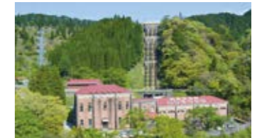
東横山発電所
