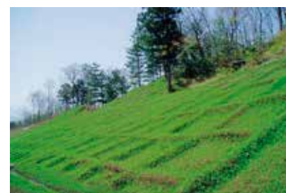
GTフレーム工法®によるのり面
