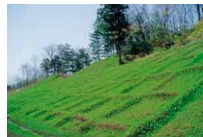
GTフレーム工法®によるのり面
